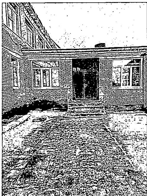
Фото №9 – Запасной выход
